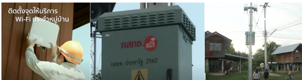
ภาพ 12 การติดตั้งจุดกระจายสัญญาณเน็ตประชารัฐ
